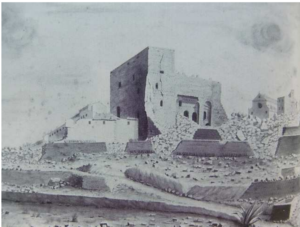
Destrucció i runes del Pretori i voltants
