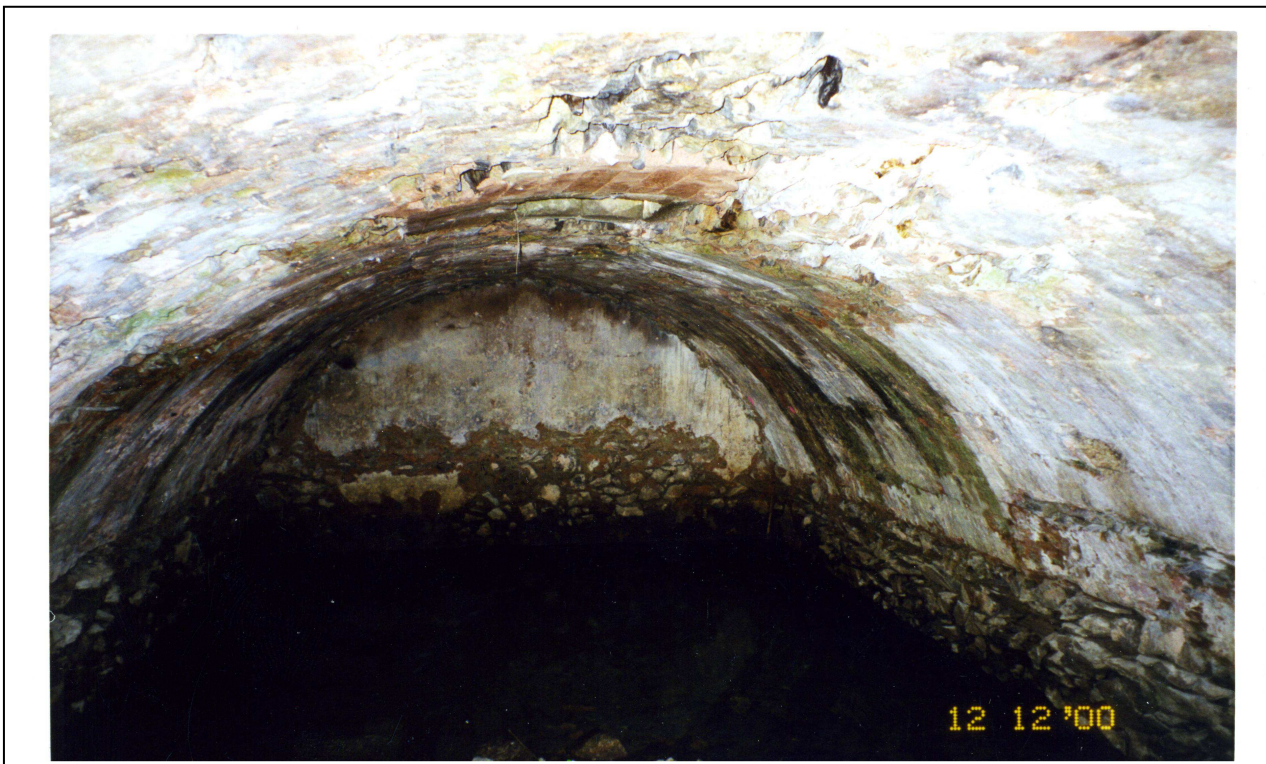
Figura 1: Cisterna principal del castillo de Llivia. Esta es una estructura excavada en la roca y cubierta por un arco de obra que permitía asegurar la provisión de este preciado elemento a los defensores del castillo. Al mismo tiempo, la torre del homenaje gozaba de su propia cisterna, de idénticas características pero menor dimensión.
