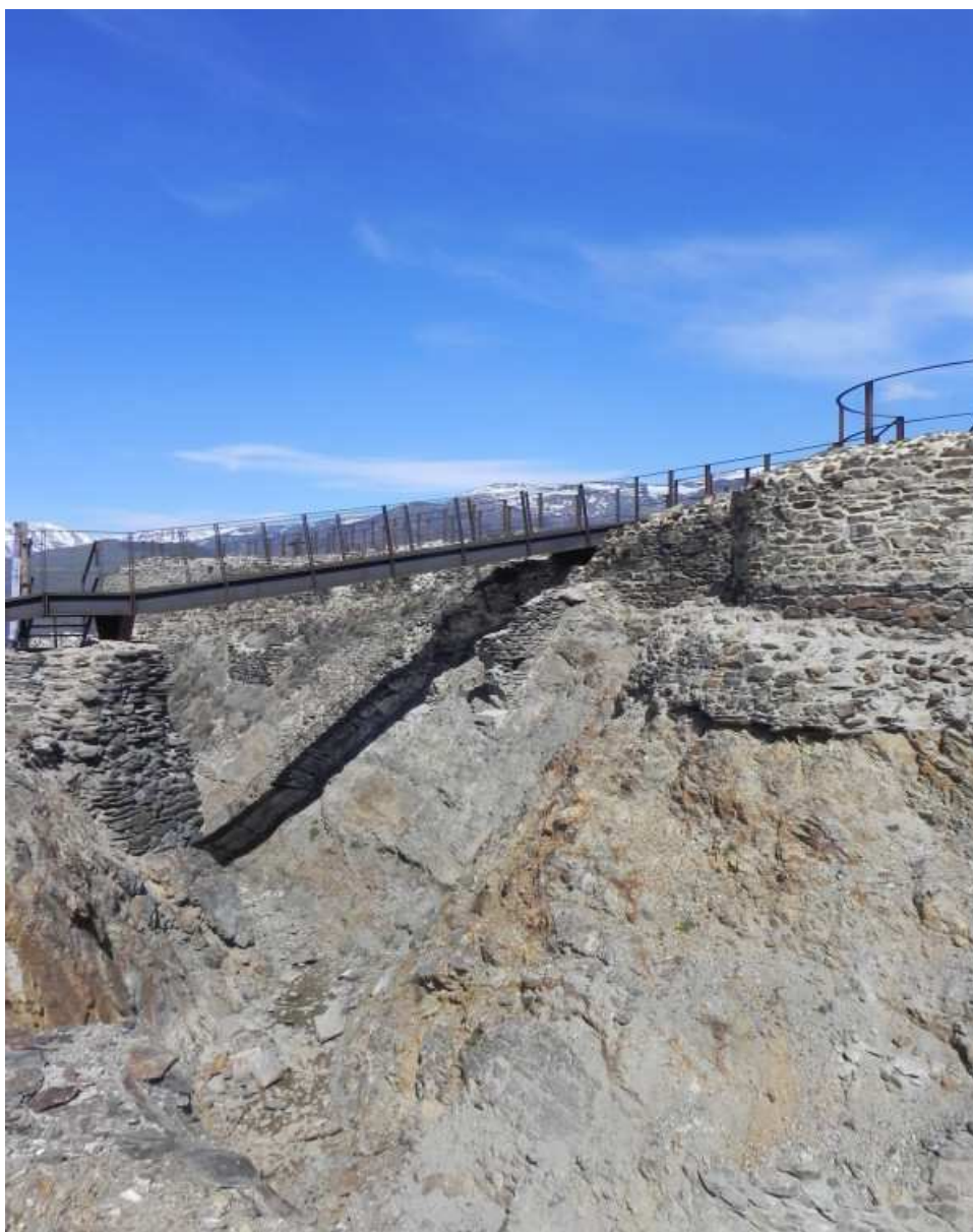
Figura 7: Vista parcial de la fachada sur del castillo una vez restaurada. Los muros se han consolidado para evitar la degradación mediante su rejunte con mortero de cal, mientras que para facilitar la visita se ha construido una pasarela de obra, hecha de acero patinable (tipo corten ) y madera; y un puente, de idénticos materiales, que permite atravesar el foso recuperado en su totalidad.
