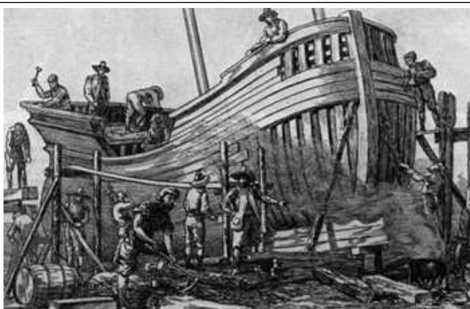
Operaris construint un vaixell [ www.junglelightspeed.com/files/shipbuilding.jpg ]
