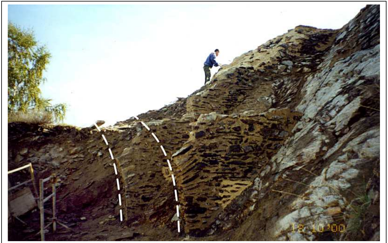
Figura 2: Restes de les arcades del pont que comunicava la torre de l'homenatge amb l'exterior. Es tractava d'un pont d'obra (si més no els seus arcs) que permetia travessar ràpidament el fossat. Tenia una doble funció: donar als defensors del castell una sortida, en cas que la fortalesa fos presa i, alhora, facilitar possibles sortides dels defensors per atacar als assetjants. [Lluís Bayona i Prats © Servei de Monuments de la Diputació de Girona]
