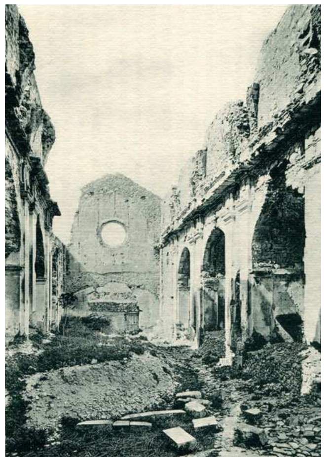
Vista general de l'església del monestir de Santa Maria de Gràcia a principis del segle XX. Hom pot observar com el conjunt fou saquejat totalment en el moment de produir-se l'exclaustració i utilitzat com a pedrera per obtenir materials de construcció, de manera que s'ensorrà ràpidament. Avui, acull el museu d'arqueologia d'Empúries.
