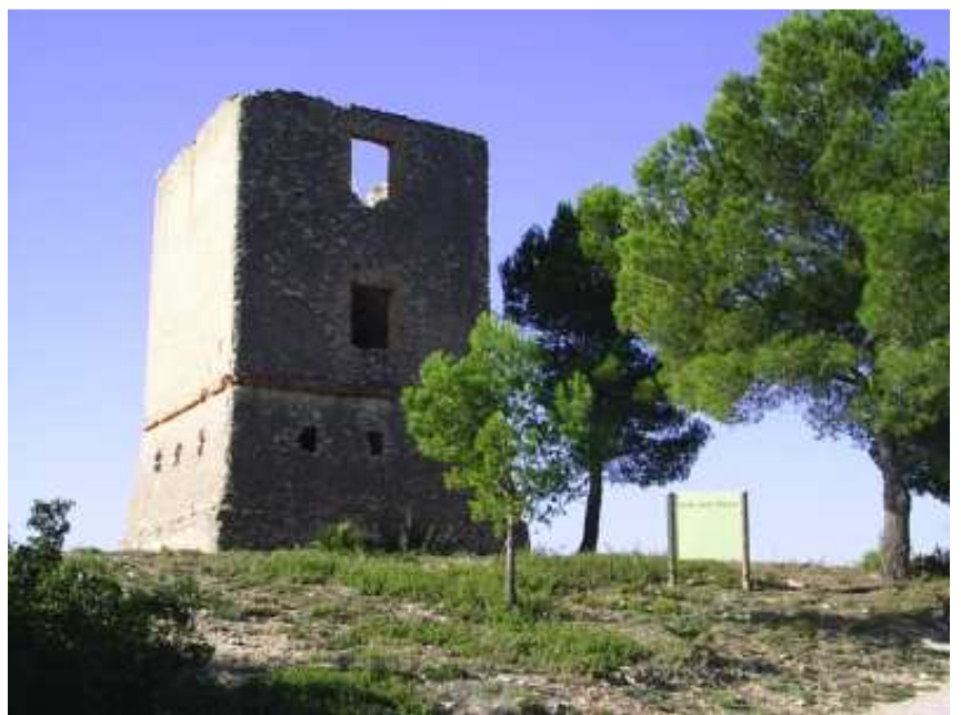
La Torre dels Moros, de El Perelló
